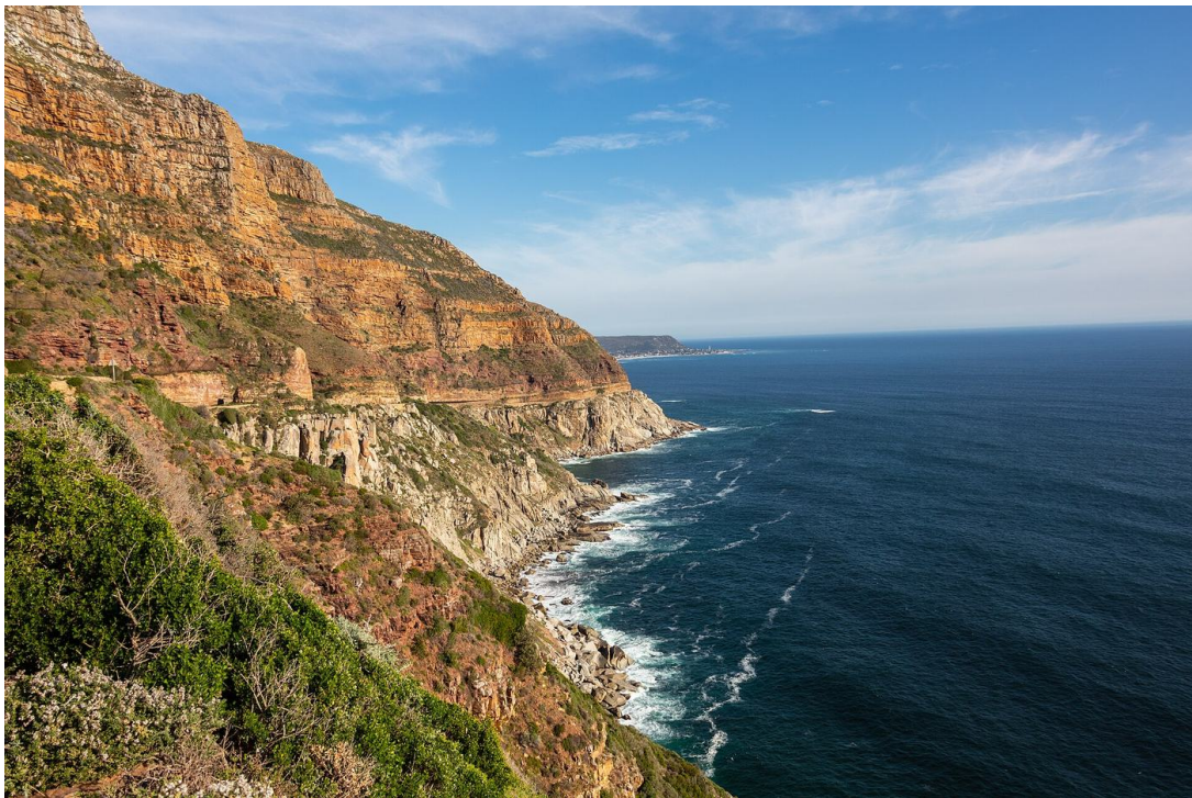
Chapman's Peak Drive – in den Fels gesprengt, ein Meisterwerk kühnen Straßenbaus · Chapman's Peak Drive – blasted into the cliff, a masterpiece of daring road building
